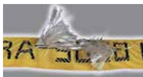
Повреждение внутренних прядей
